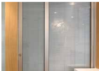
Dettaglio della parete manovrabile insonorizzata in vetro con tenda veneziana inserita Detail of the movable sound-insulated glass partition with Venetian blind inserted
