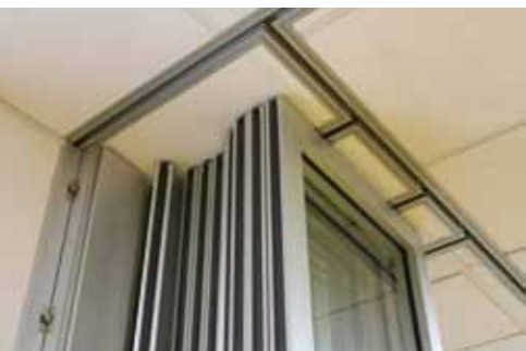
Dettaglio di impacchettamento Detail of the storage system
