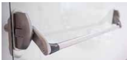
Dettaglio di maniglia e maniglione antipanico Detail of door handle and anti-panic push bar
